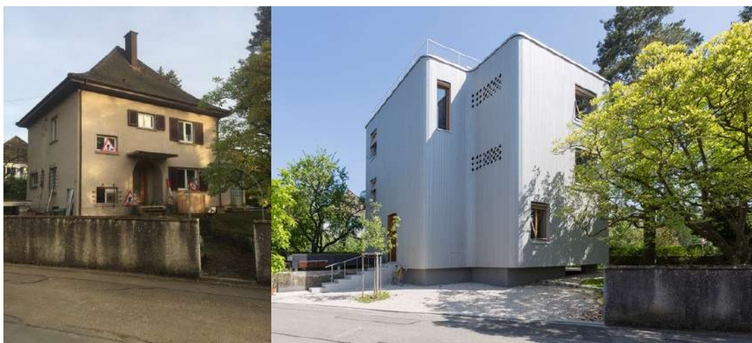
Abbildung 36: MFH in Wettingen AG, vor Sanierung (links) und nach Sanierung (rechts) (Quelle: Hürzeler Architekten AG)
