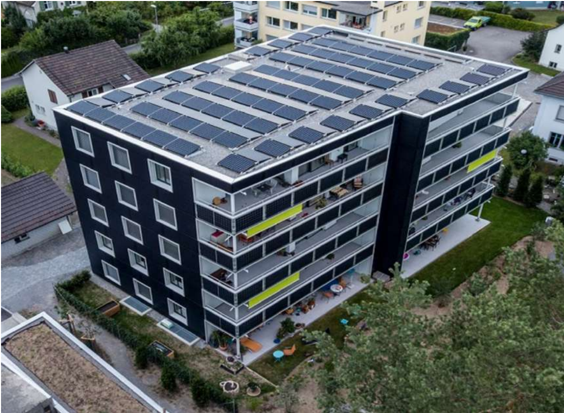
Abbildung 42: MFH in Wetzikon AG mit PV-Anlagen auf Dach und Fassaden (Quelle: Arento AG)
